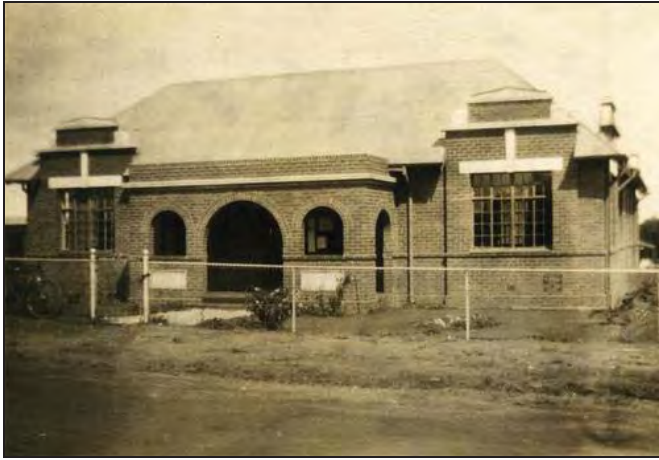
Die Munisipale kantoor 1934, Hoek van Hendrik Verwoerd Straat (Was Commisioner Straat) en Tweede Laan
