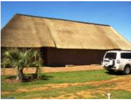
Nuwe, moderne ablusieblokke
