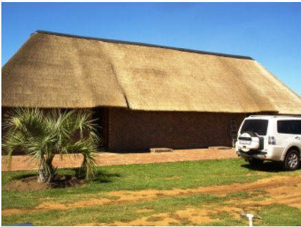
Nuwe, moderne ablusieblokke
